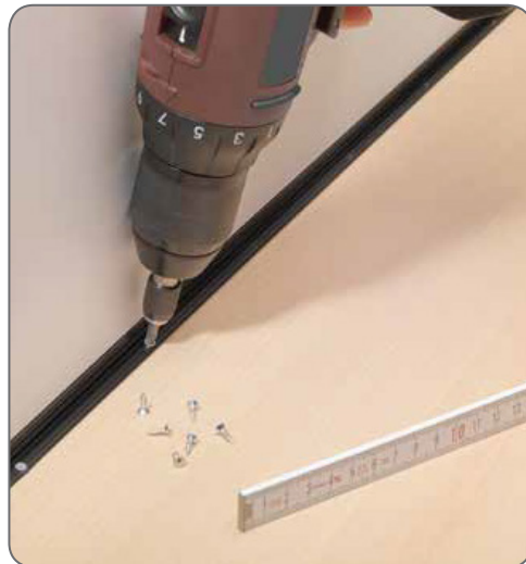
4. Закрепить шурупами. (шурупы с потайной головкой 2,5 x 10)
